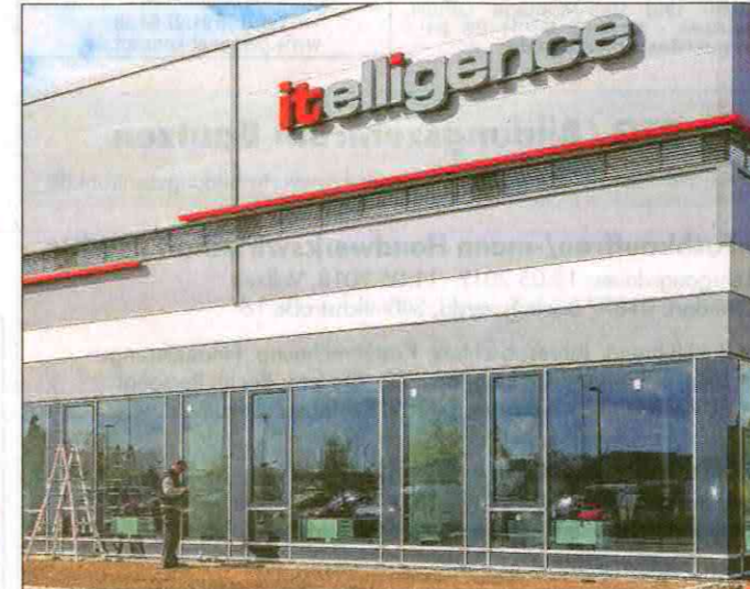
Letzte Arbeiten an der Schliebenstraße: Das neue Itelligence-Rechenzentrum soll am 4. Mai seinen Betrieb aufnehmen.
